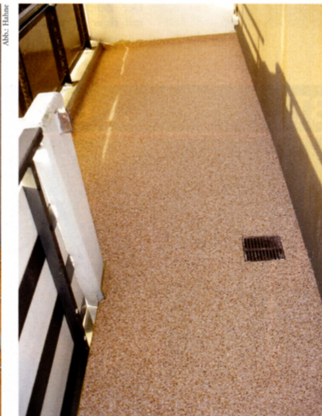
Abb. 1 + 2: Vor und nach der Balkonsanierung, hier naht- und fugenlos
