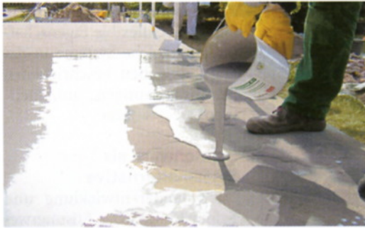
Abb. 4: Rissüberbrückung mittels PU-Harzbeschichtung
