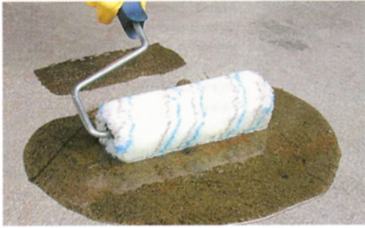
Abb. 3: Haftverbund herstellen mit Grundierung
