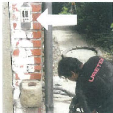
Abb. 11: Anheben der Ecke vom Schlossgebäude – Positionsmessgerät zum Erfassen des Injektionsfortschrittes
