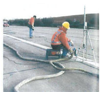
Abb. 9: Fugen und Betonstrecke wieder befahrbar gemacht bei laufendem Autobahnverkehr
