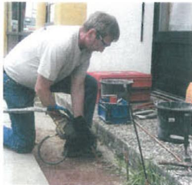
Abb. 6: Injektion nach Untergrundanalyse
