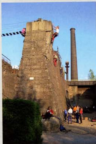
Abb. 3: Alter Beton – alpine Gipfelstürmer
