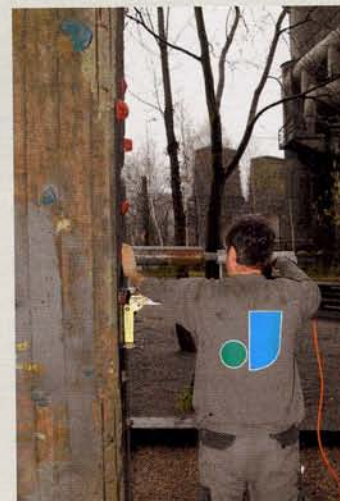
Abb. 6: Entnehmen eines Bohrkerns
