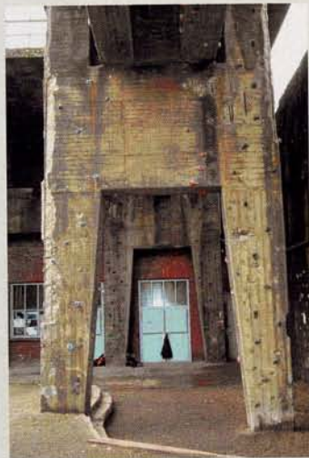
Abb. 4: Pfeileroberfläche mit Sekundäroberfläche
