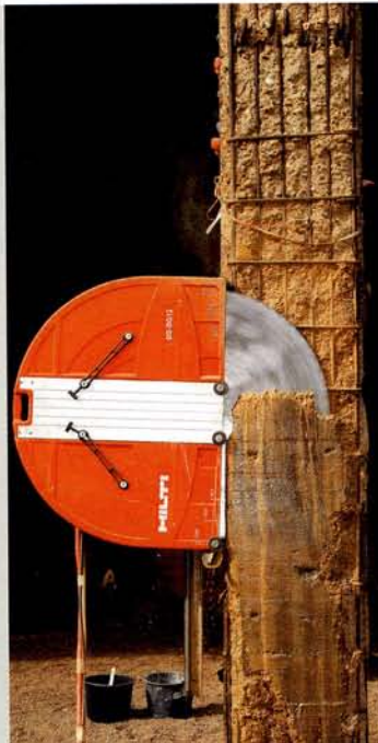
Abb. 12: mit denkmalpflegerischem Ermessen eingesetzt
