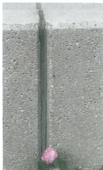
Abb. 9: Nötige Erneuerung horizontaler und vertikaler Fugen nach Abriss des alten Dichtstoffes an den Betonfertigteile-Flanken
