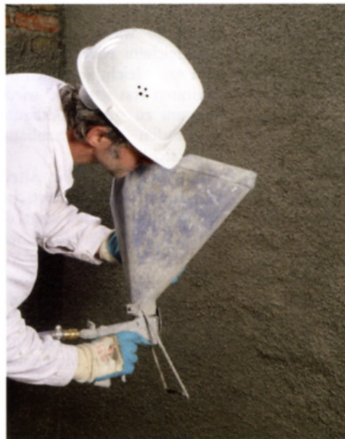
Abb. 3: Wenn Vorspritzmörtel eingesetzt wird – dann auf die eingezogene, feuchte Schlämme oder am nächsten Tag.
