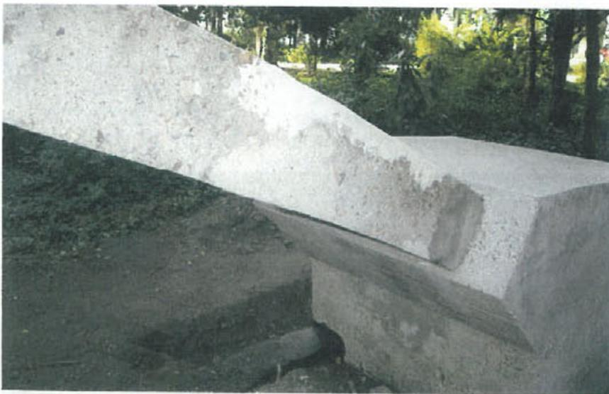
**Abb. 3 + 4:** Reinigen des historischen Betons durch Hochdruckdampfverfahren
