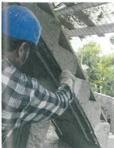
Abb. 9: ... danach Einbau der CFK-Lamellen
