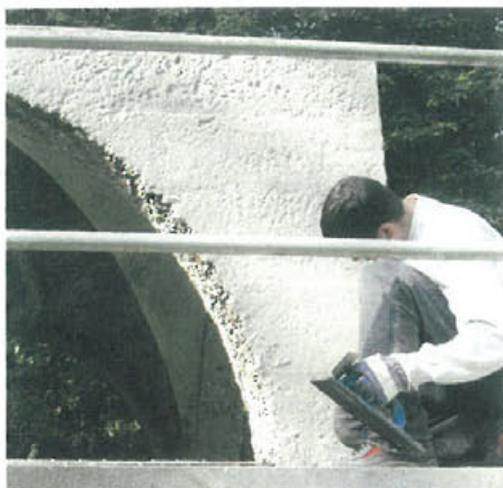
**Abb. 10:** Putzbeschichtung zwecks Porenverschluss
