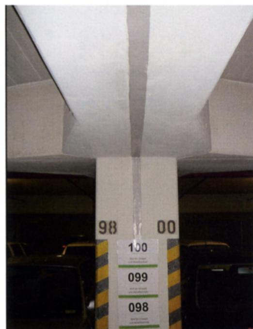
schlossen werden. Insgesamt 500 Meter Bauwerksfugen wurden abgedichtet, (Abb. 9 und 10). Ein weiterer Bestandteil der Arbeiten war auch die Instandsetzung von 5.500 m<sup>2</sup> Betonfläche. Zu allen Details informiert nachstehend der Kastentext.
