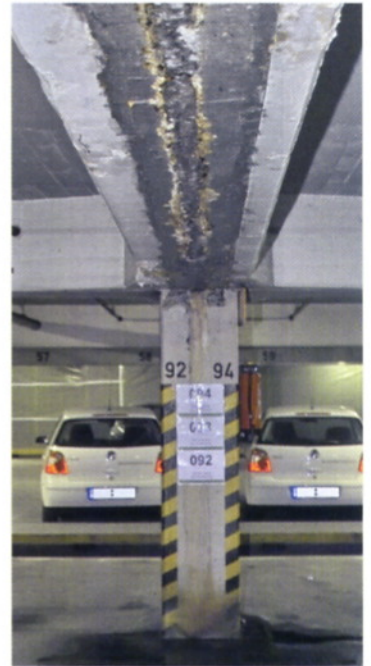
Computerkontrollierter Packereinsatz im Landratsamt Karlsruhe zur Fugenabdichtung in der Tiefgarage
