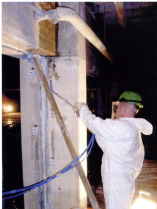
Abb. 7: 2-k-Injektion bei einer Bewegungsfuge zwischen zwei Stützen
