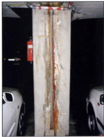
**Abb. 4:** Typisches Feuchteschadensbild in der Tiefgarage, hier an einem Stützpfeiler
