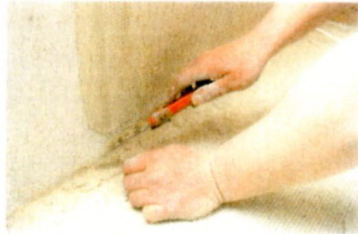
Abb. 6: Überstehendes Armierungsgewebe wurde mit dem Cutter abgeschnitten.
