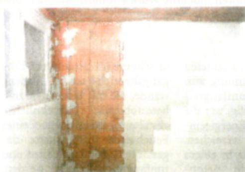
**Abb. 3:** Der Ausgleichsputz bietet die Ebenheit, die für die Verarbeitung der Mineraldämmplatten erforderlich ist.
