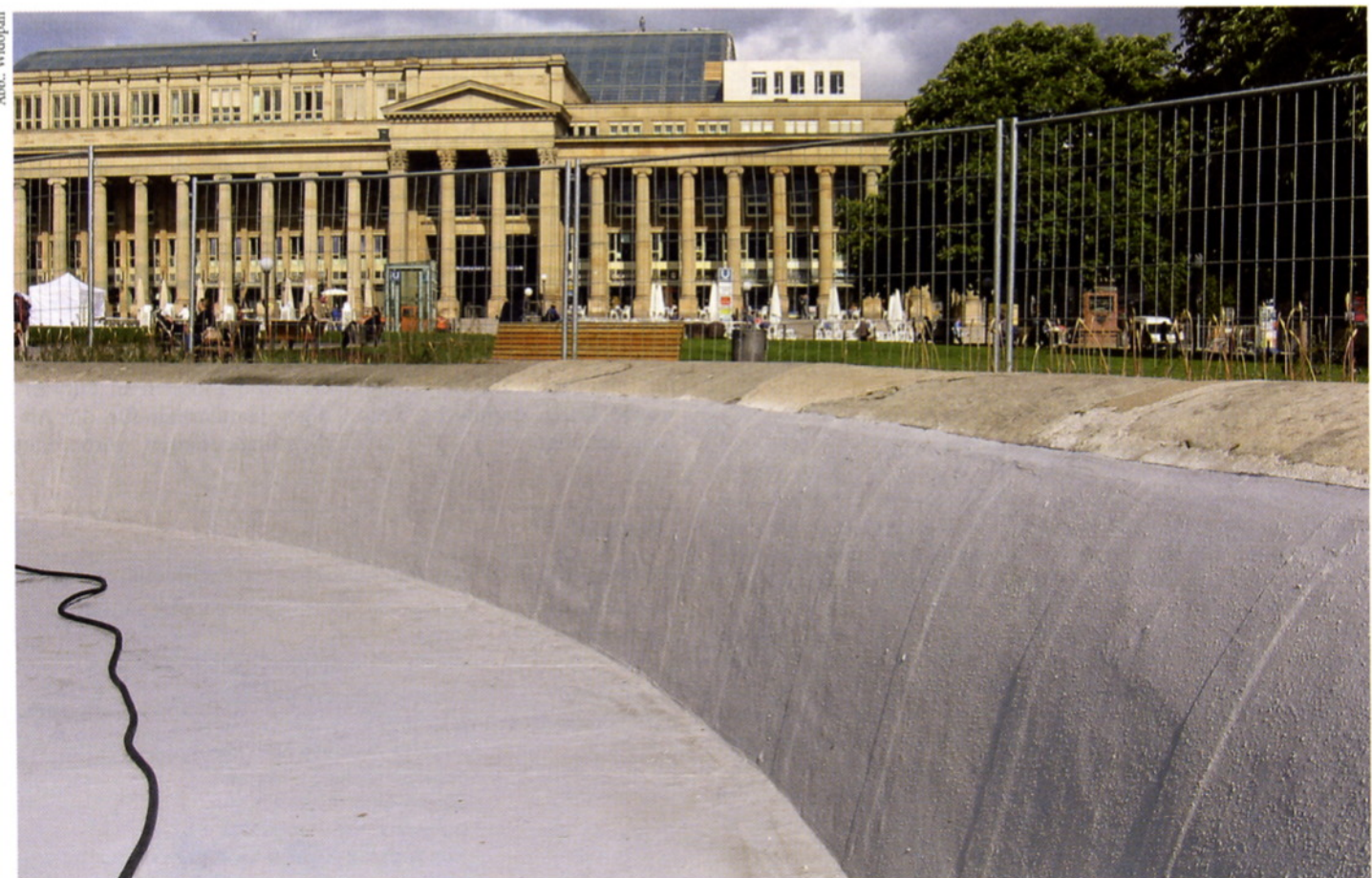
Abb. 1: Schlossplatz Stuttgart – seine beiden Brunnen wurden mit einer Flüssigabdichtung auf PMMA-Basis instand gesetzt.
