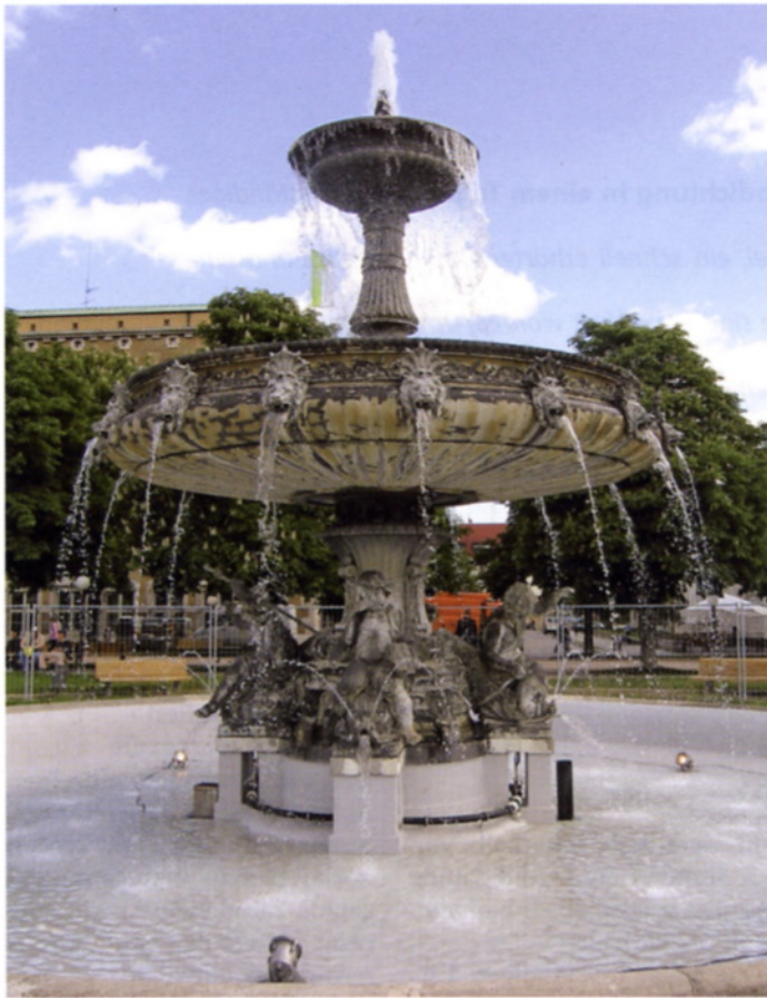
Abb. 5: Einer der beiden wiederhergestellten Brunnen nach Ende der Abdichtungsarbeiten. Diese schützten auch gegen mechanische Belastungen durch badende Fans während der Fußballweltmeisterschaft 2006.
