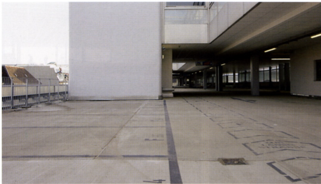
Abb. 3: Fertige Betonoberfläche der Lastverteilungsplatte ohne zusätzliche Beschichtung
