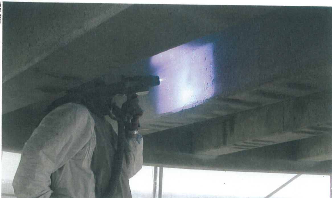
Abb. 1: Das Verfahren des Lichtbogenspritzens: Zinkmetall wird geschmolzen, per Gasstrahl zerstäubt und auf den Beton geschleudert
