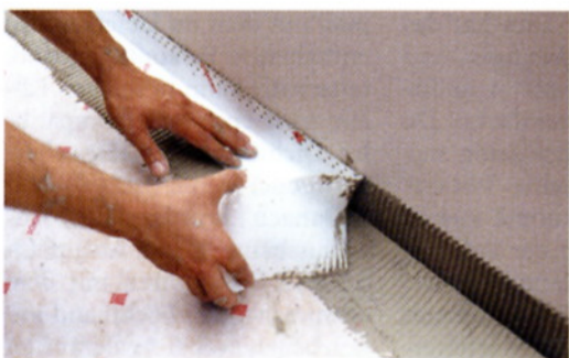
Abb. 7: Verkleben des Dichtbandes auf der Folienbahn
