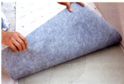
Abb. 6: Einlegen der Folienbahn
