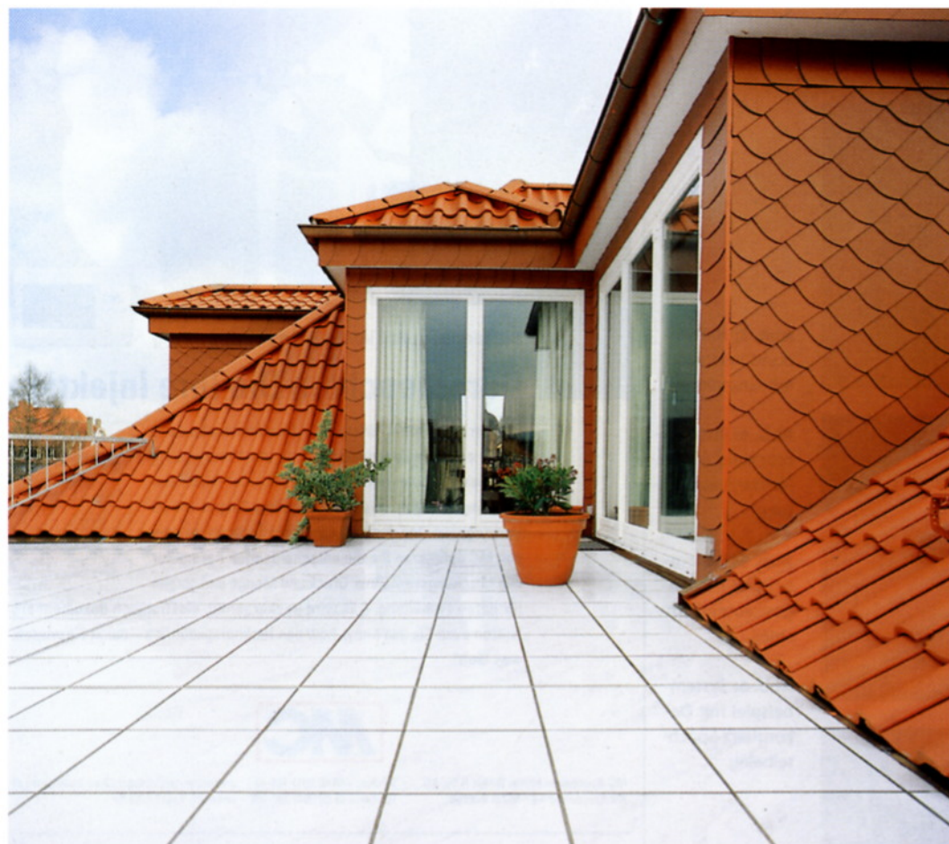
Abb. 1: Dauerhaft abdichten und schadensfrei Belag aufbringen – wie bei einem Großobjekt in Berlin in 172 Fällen.
