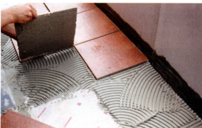
Abb. 8: Keramikverlegung in direktem Verbund mit dem Systemkleber
