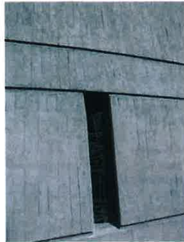
Bild 3 Die fertige Oberfläche.
