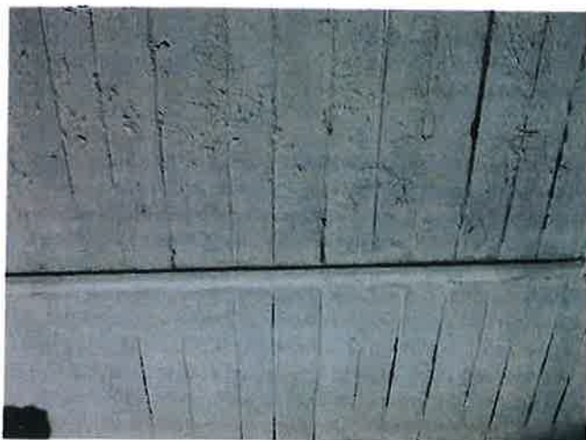
Bild 4 u. 5 Neue und alte Scheinfuge.
