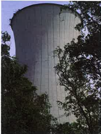
Rund 110 m ist der Kühlturm hoch, an der Basis misst er etwa 75 m und im oberen Teil beträgt der Durchmesser ca. 52 m.
