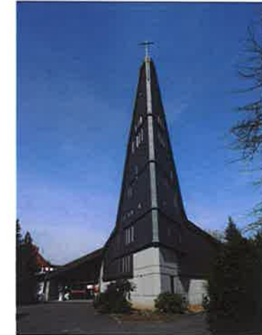
Eine typische Kirche der 60er Jahre: Nach der Instandsetzung wurde der untere Fassadenbereich als Sichtbeton ausgearbeitet, während der obere Bereich nach Abstimmung zwischen dem Bauherrn, der evangelischen Kirchengemeinde Sarnau sowie der beteiligten Architekten Himmelmann und Schneider-Lange eine Vorsatzschale aus Schiefer erhielt. Gut zu sehen die Scheinfugen, die die Oberfläche strukturieren.
