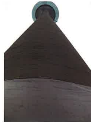
Der Turmunterbau nach der Fertigstellung: Die Optik hat sich durch die Instandsetzung nicht verändert.
