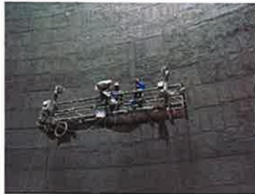
Gearbeitet wurde von zwei Motor-Hängegerüsten aus, die horizontal über den gesamten Umfang des Kühlturm-Innenraumes verfahrbar waren. Die Arbeiter hatten in der Breite nur knapp fünf Meter Platz zur Verfügung.
