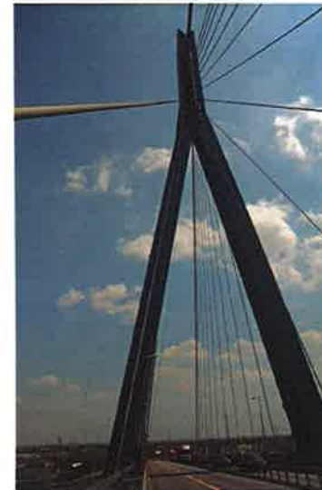
Mit den beiden weithin sichtbaren 135 Meter hohen Pylonen prägt die 3,6 km lange Hamburger Köhlbrandbrücke die Kulisse des Hamburger Hafens.
