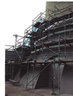
Die Maßnahme kurz vor der Fertigstellung. Die Reprofilierungen wurden so dezent wie möglich ausgebildet, um sichtbare „Reparaturstellen“ zu vermeiden, gleichzeitig aber so dick, wie für den Bewehrungsschutz notwendig. Bildnachweis (4): Massenberg GmbH, Essen
