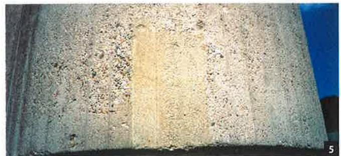
**Abb. 5:** In die neue Richtlinie wurden für die Planung von Instandsetzungsmaßnahmen auch geringere Betonuntergründe aufgenommen, da dieser Anwendungsfall häufiger vorkommt. Sie werden in Altbetonklassen eingeteilt, um geeignete Instandsetzungsprodukte darauf abstimmen zu können.
