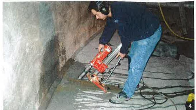
**Abb. 4:** Die Beschaffenheit des Betons und des Betonuntergrunds bildet die Basis für die Planung der Instandsetzungsmaßnahmen. Sie ist im Vorfeld der Planung auch mit Untersuchungen an Bohrkernen zu ermitteln.
