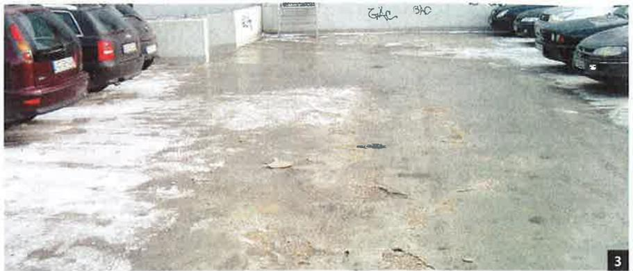
Abb. 3: Bei diesem Oberflächenschutzsystem wurde auf eine Wartung verzichtet – mit entsprechend negativem Resultat.
