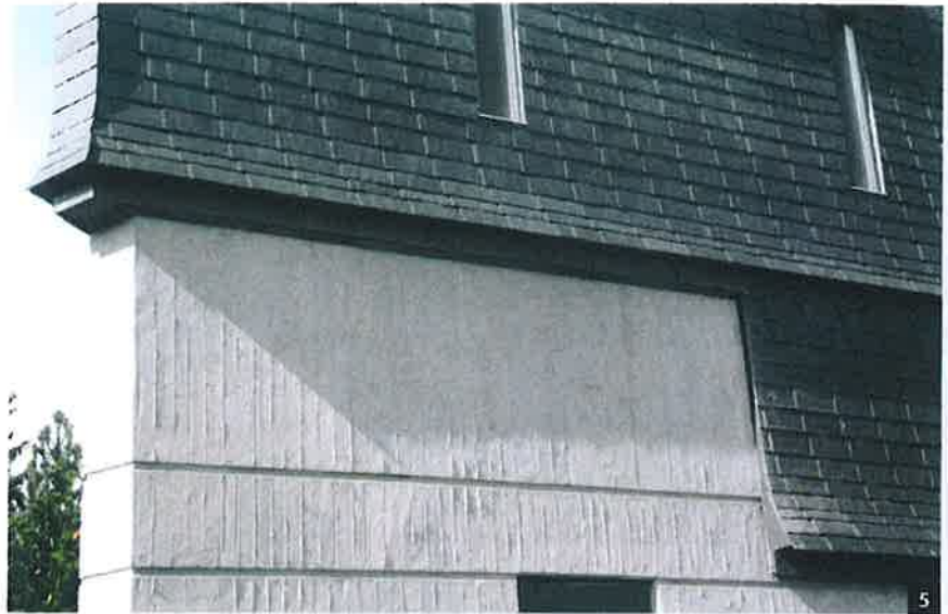
Abb. 5: Nach der Instandsetzung wurde der untere Fassadenbereich als Sichtbeton ausgearbeitet. Der obere Bereich erhielt eine Vorsatzschale aus Schiefer.
