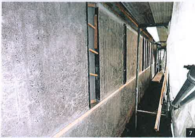
Abb. 7/8: Die ursprünglichen Scheinfugen konnten durch Montage einer Holzkonstruktion, die nach dem Aushärten wieder entfernt wurde, wiederhergestellt werden.
