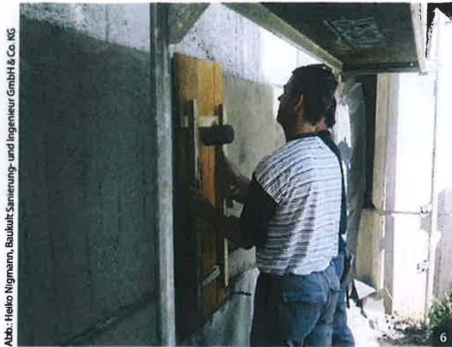
Abb. 6: Durch das Eindrücken einer Brettschablone in die frische Oberfläche wurde die alte Struktur des Betons rekonstruiert.
