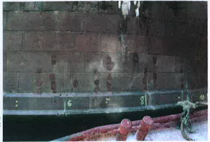
Die wieder verschlossenen Bohransatzpunkte an einem Pfeiler der Alten Brücke in Frankfurt am Main.
