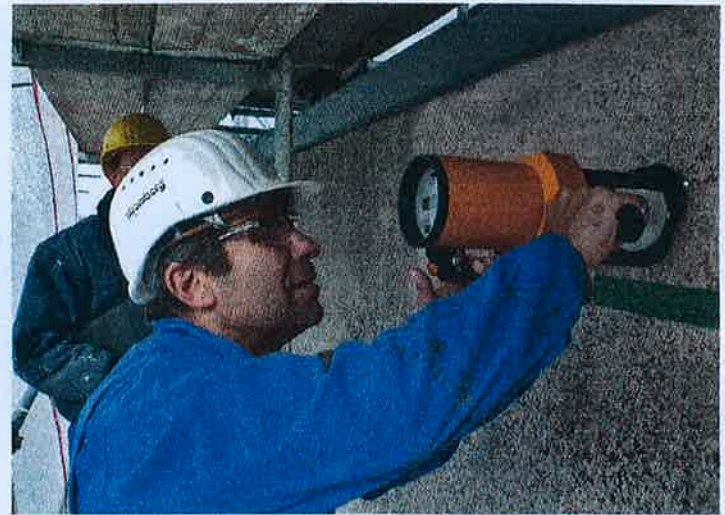
Oberflächenzugfestigkeitsprüfung, auf gestrahltem Betonuntergrund
