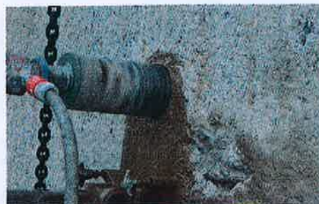
Kernbohrung
