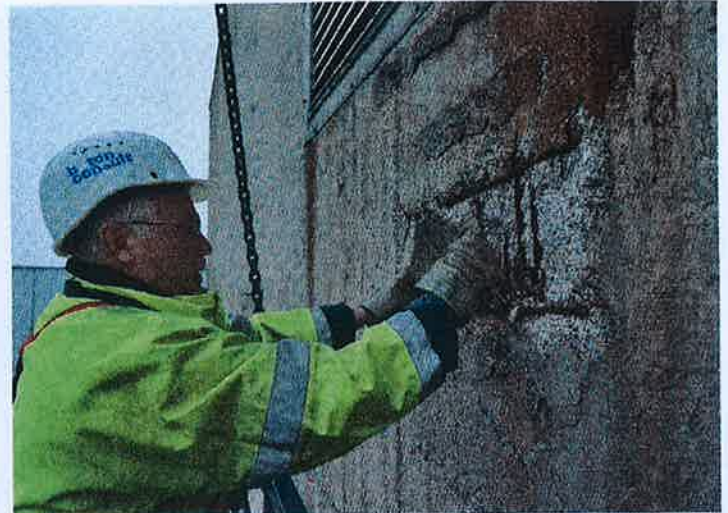
Untersuchung der Schadstellen
